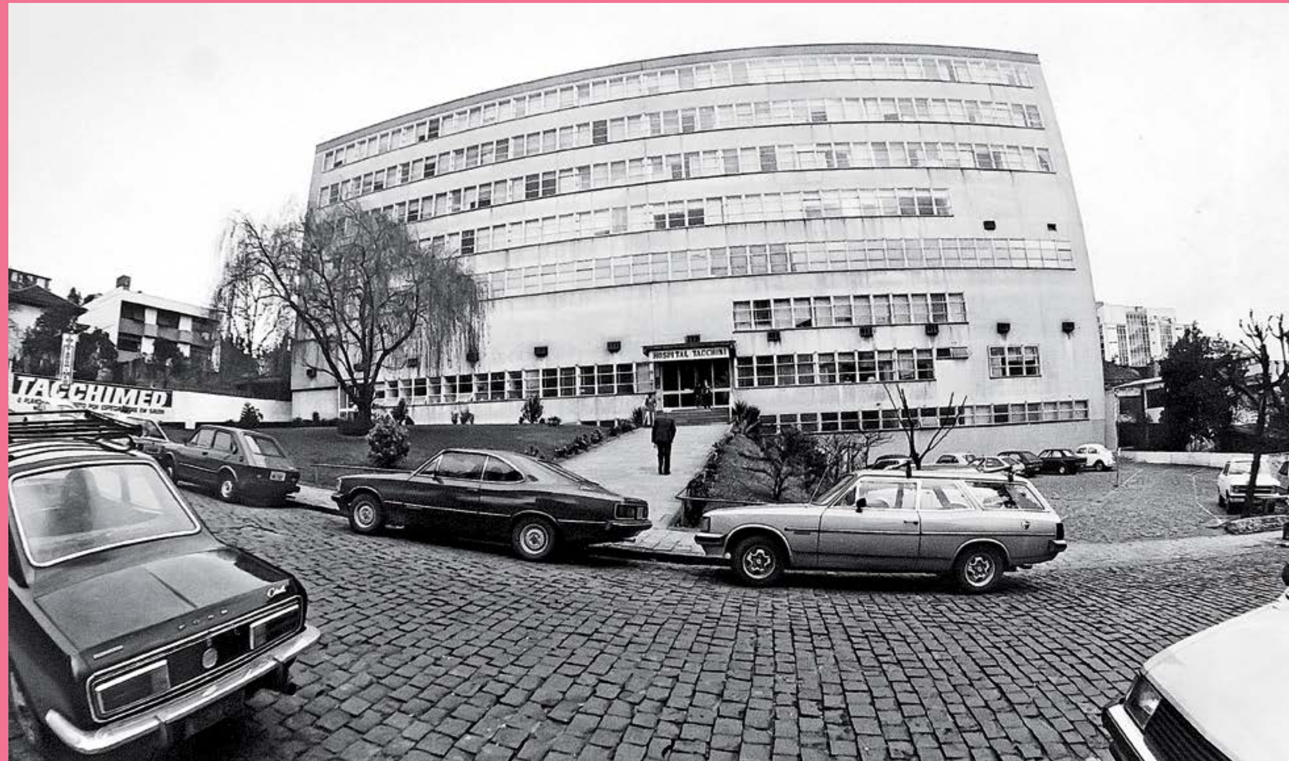
Fachada do Hospital Tacchini em 1985
