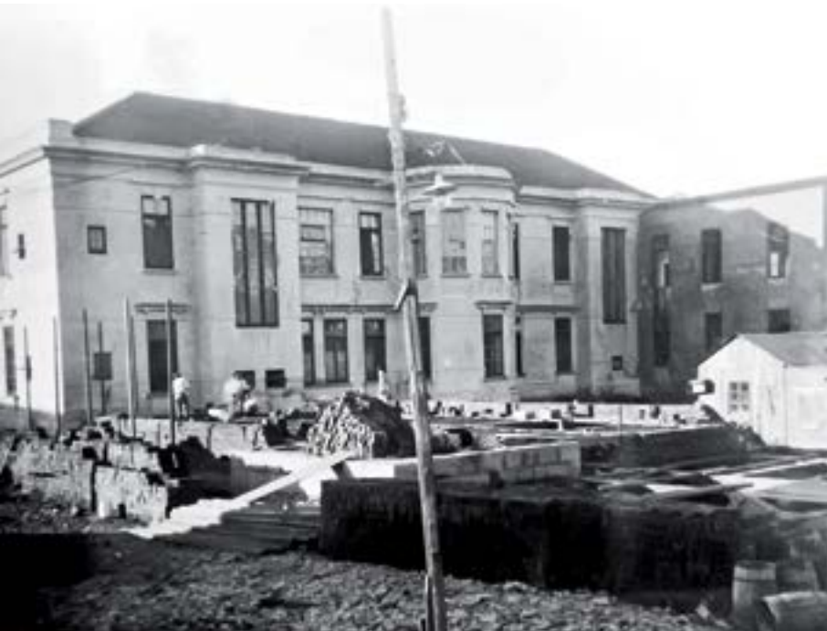
Construção do segundo pavilhão do Hospital
