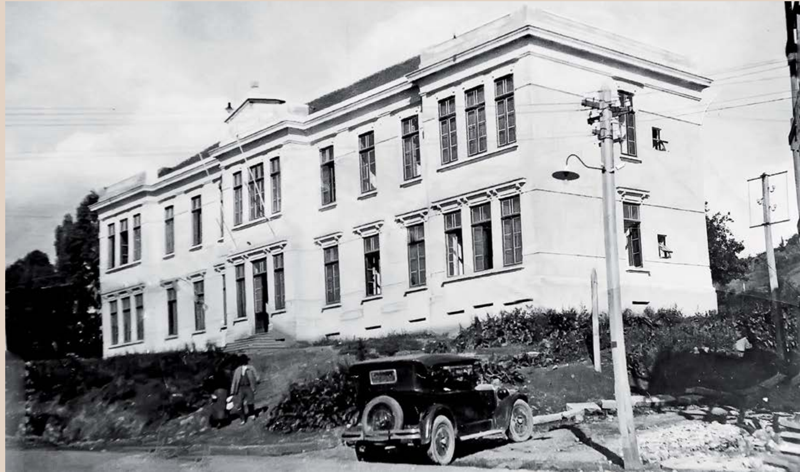
Prédio do Hospital Dr. Bartholomeu Tacchini, inaugurado em 1927
