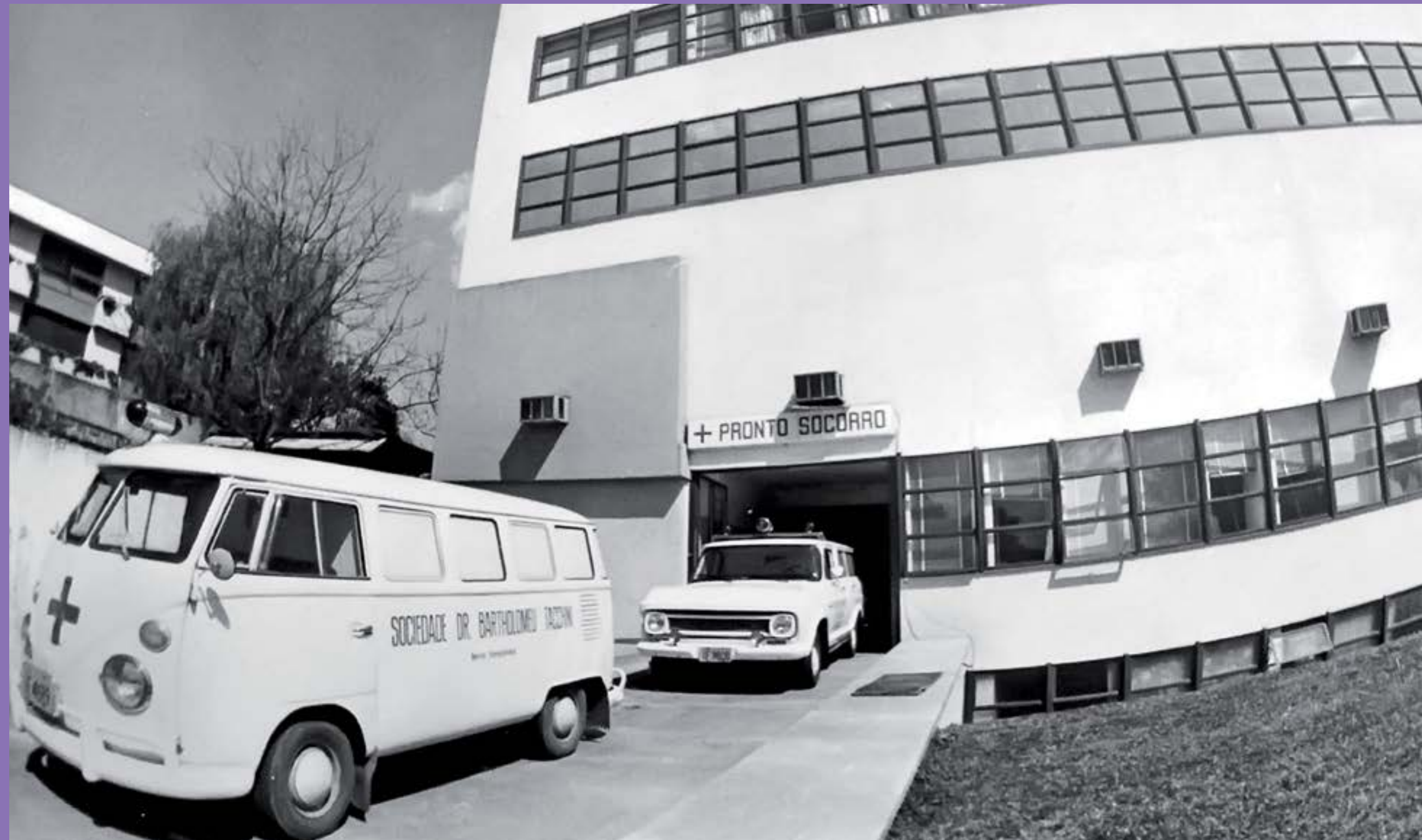
Pronto-Socorro é instalado no novo prédio (B)
