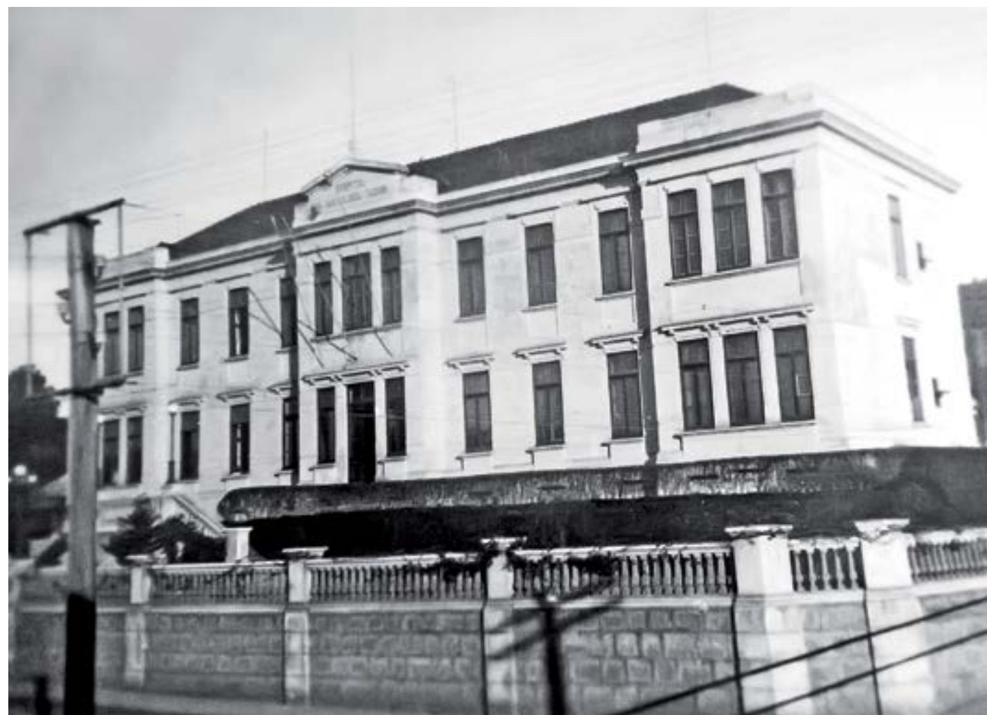
Evolução das obras, com construção de escadarias, portões e calçada
