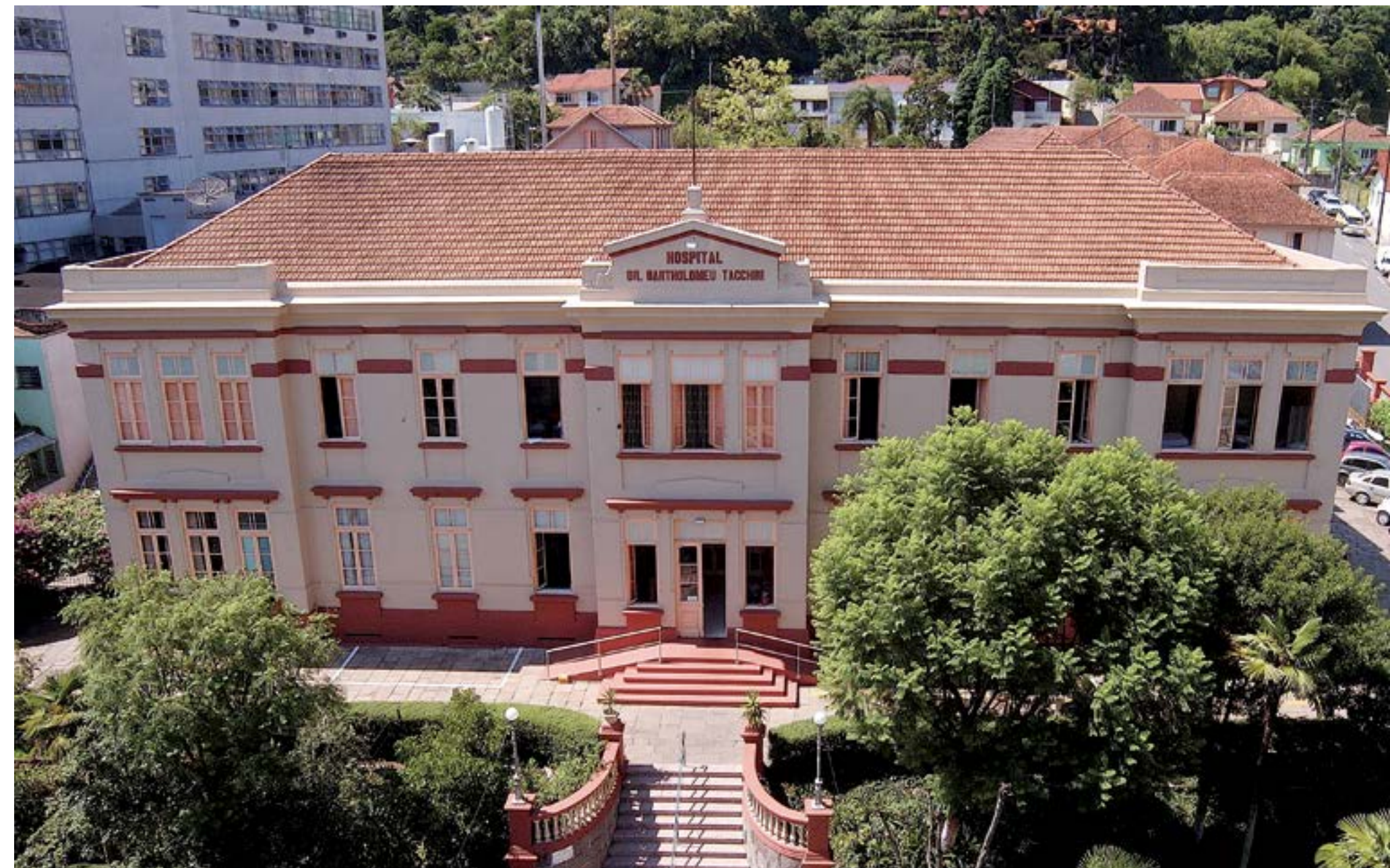
Manutenção da fachada do Prédio A
