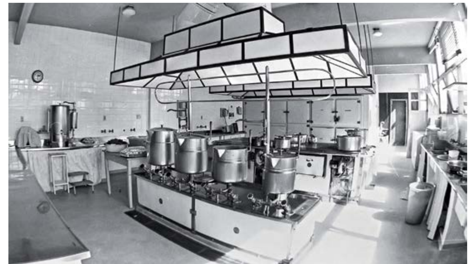
Reforma da cozinha geral
