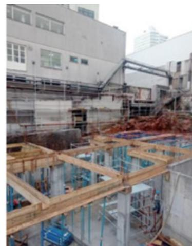
*Prédio das Engenharias, construção de estrutura em concreto armado, viabilizando confecção de passarela de acesso entre prédios e estação de tratamento de efluentes. Edificação com cinco andares, realizada contenção de solo, escavação, detonação e estruturas em concreto armado*
