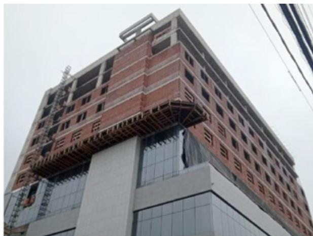
*Fechamento do prédio Tacchimed, envolvendo execução de serviços de alvenaria, reboco, fachada aderida, fachada ventilada, esquadrias, pele de vidro e brises*
