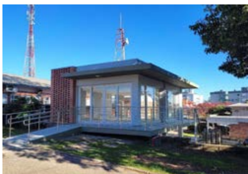
Construção do estar para funcionários
