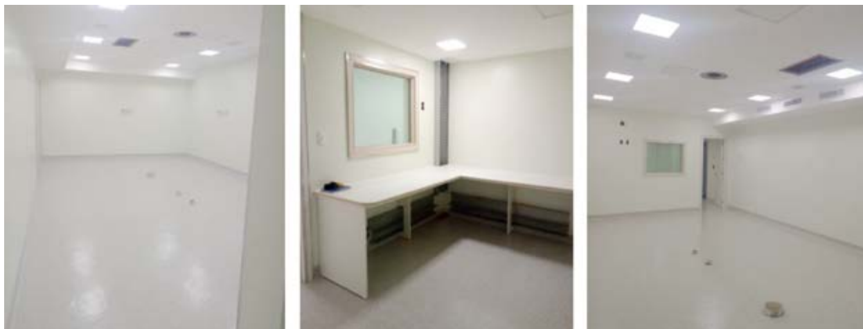
Construída sala para receber novo equipamento de Hemodinâmica GE adquirido em 2022
