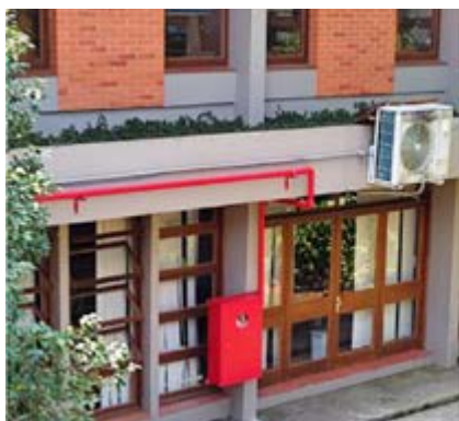
Nova rede de hidrantes para adequação ao PPCI
