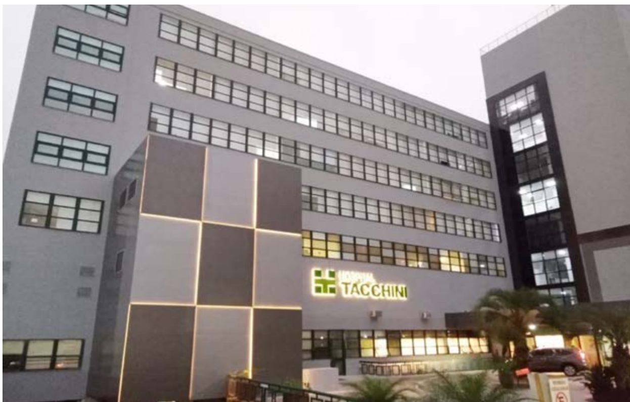
Realizada a pintura externa do prédio B
