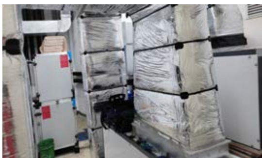
Readequação do ar condicionado do CME
